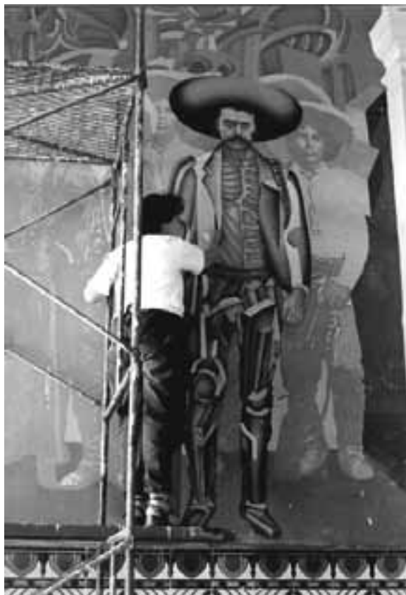
Proceso de intervención.
