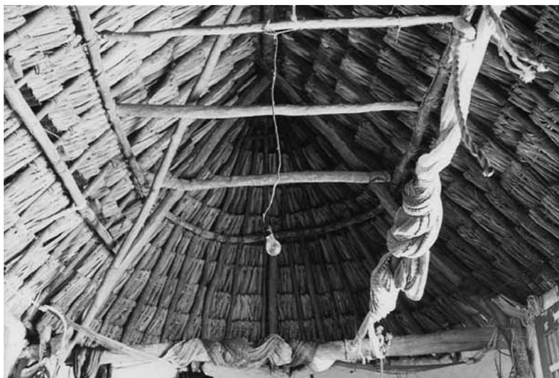
FOTO 1. Interior de la cubierta de una vivienda maya contemporánea con el colgado de hamacas en la estructura de madera. Nunkuní, Campeche
