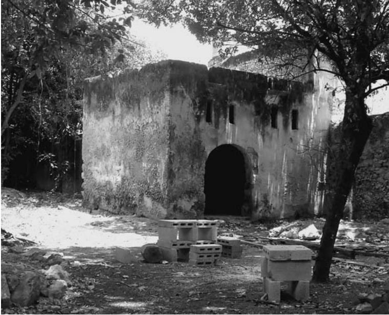
FIGURA 6. La garita antes de su remodelación (foto Eugenia Montalván).
