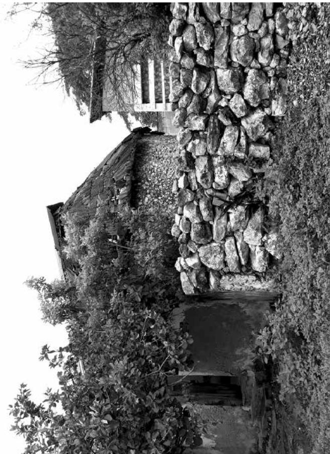
Se observa el techo cubierto con tejas de material reciclado (debido a la dificultad para encontrar paja en la región) y el muro de piedras. Fotografía de Cecilio Cocom. Mérida, México, 2018.<sup>7</sup>
